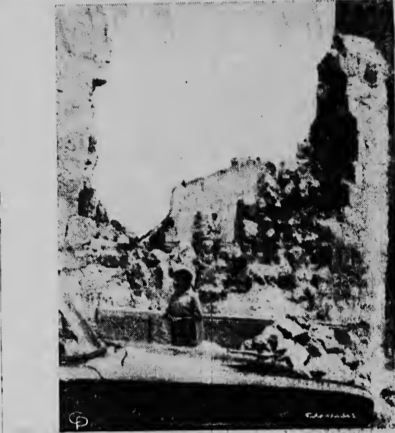
Dit zijn de gevolgen van een aardbeving. Een der beschadigde gebouwen te Arequipa (Peru). Het lijkt wel een bominslag.
